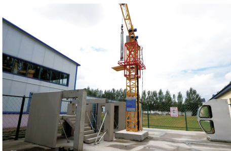
建筑工程施工实训基地
